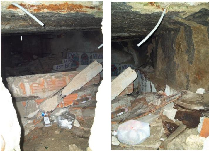
Figure 11 – Vue de l’intérieur de la casemate nord. Décharge insalubre et déjà visitée comme les démontrent les graffitis, les poutres sont des éléments extérieurs effondrés qui ont été placés dans la casemate avant condamnation. La poutre en oblique du premier plan semble être une asperge de Rommel.
