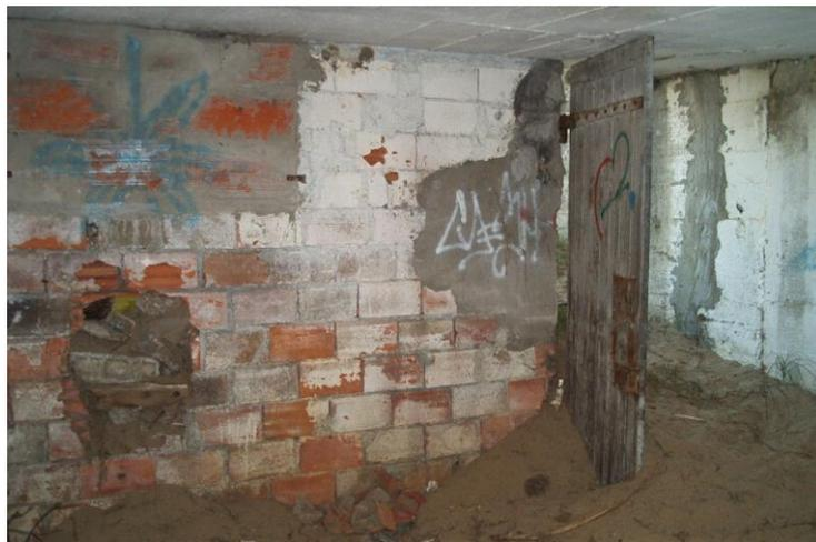
Figure 16 – L’intérieur de l’abri pour personnel. L’état des lieux est, dans l’absolu, convenable, malgré l’apparition de fissures dans les murs issues des bombardements qui ne présagent pas une conservation durable. Le mur de briques, ainsi que la porte en bois doublée de métal, indiquent que cette pièce était la plus éloignée de l’entrée de l’abri.
