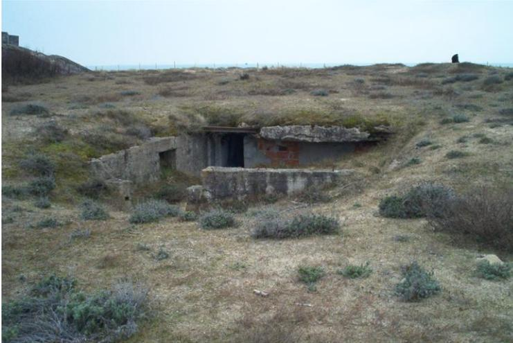
Figure 14 – L’abri pour personnel, encore incroyablement camouflé dans les dunes à l’arrière des casemates. Composé de deux salles, la première a perdu son toit par bombardement à proximité dudit bâtiment et effondrement. A gauche en arrière-plan, la casemate sud en ruines.
